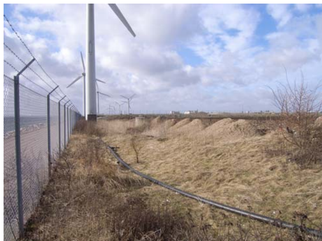
Figur 9. Dæmningen ved AV-Miljø (ved vindmølle).
