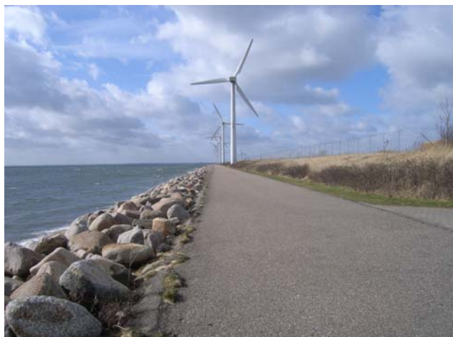
Figur 8. Dæmningen ved AV-Miljø.
