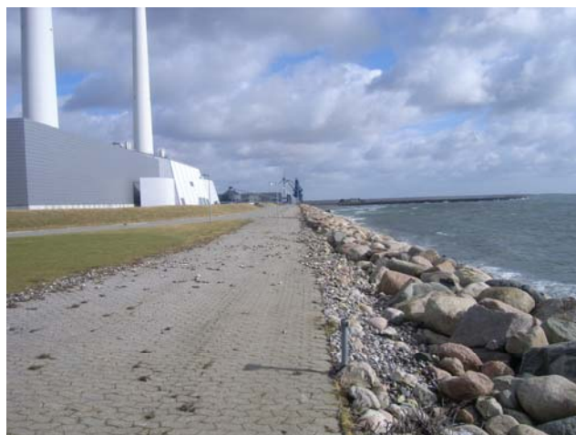
Figur 7. Dæmningen ved Avedøreværket.
